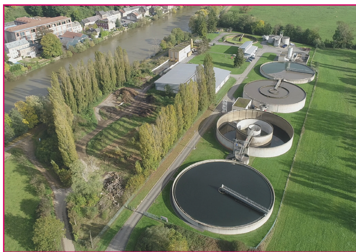
Exploitation d'équipements et de réseaux d'eau et d'assainissement 5,38 millions d'euros d'achats en 2025
